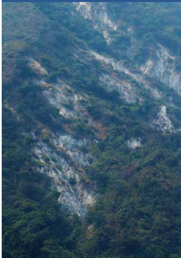
Sols propices à l'érosion sur les berges du Fleuve Congo dans le département du Pool - Crédits: Blaise Bodin
