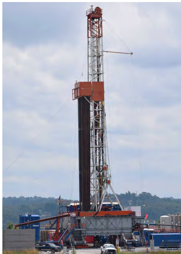
Plataforma de fracturación hidráulica en el suroeste de Pensilvania. Fotografía de Ted Auch, un miembro del personal de FracTracker Alliance, en 2016.
