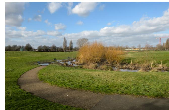
**Gráfico 12:** El Parque Sutcliffe de Londres y su paisaje, diseñado para formar embalses de agua. Plan para paliar las inundaciones del río Quaggy.
