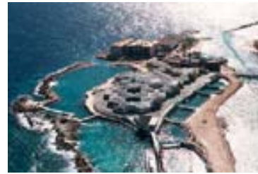
Foto 2: Vue du complexe du Seaquarium
