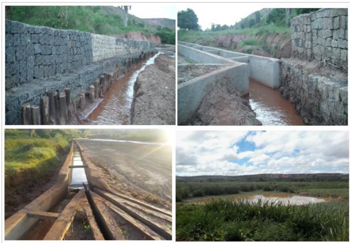
Bassin de retenue d'eau au FOFIFA CALA à Ambohitsilaozana avec les canaux d'amener d'eau
