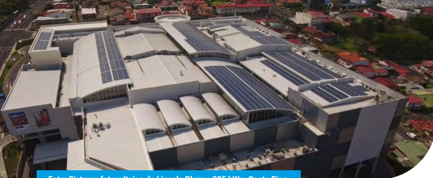
Foto: Sistema fotovoltaico de Lincoln Plaza - 325 kWp, Costa Rica.
