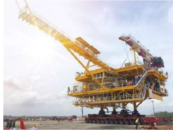
การขนส่งส่วนบนของแทนหลุมผลิตโดย SPMT มายังพื้นที่ตัดแยก
