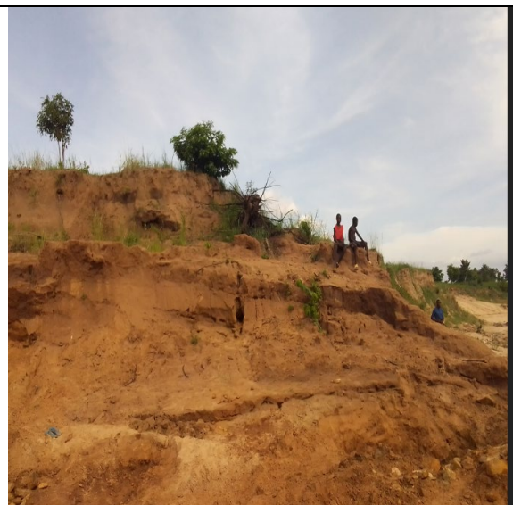
Photo 6 : Berges érodées et instables du fleuve Binah
