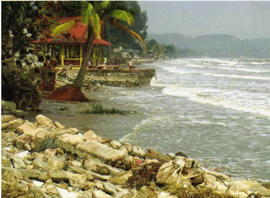
รูปที่ 2.7 สภาพการกัดเซาะชายฝั่งบริเวณชุมชนปากน้ำหลังสวน
