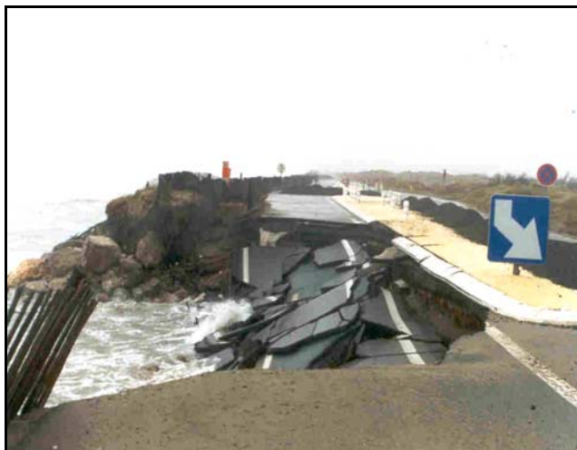
Figure 5 Les impacts des événements météorologiques extrêmes (tempêtes, surcotes marines...) sur les routes et les structures du littoral méditerranéen
