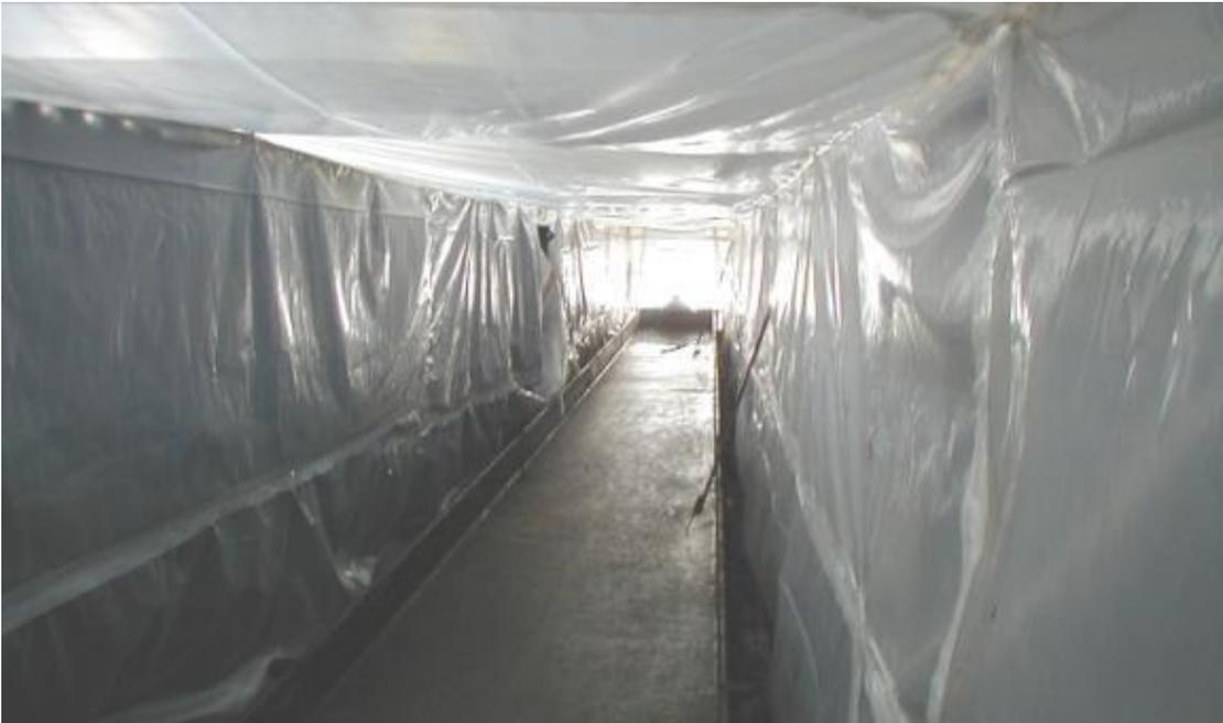
Confinamiento de las celdas (conectadas a la unidad de tratamiento del aire)
