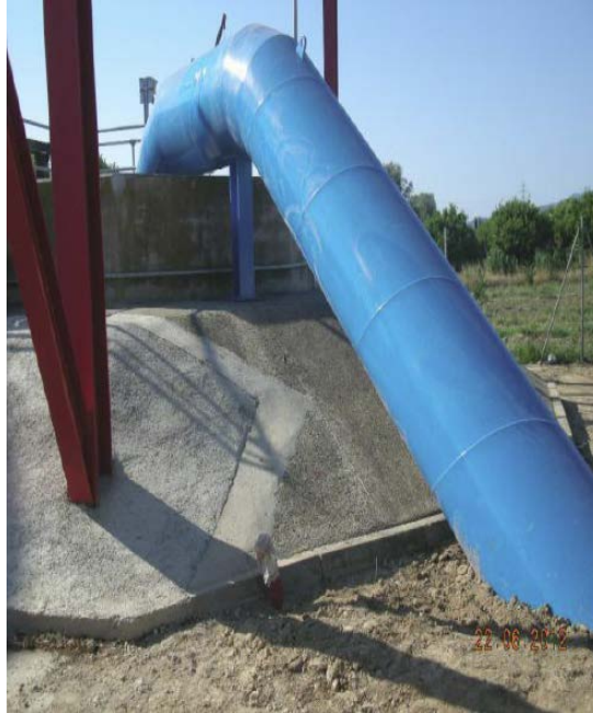
أحد الآبار التي تم بناؤها لإمداد المدن الواقعة باتجاه مجرى النهر بمياه الشرب في حالات الطوارئ
