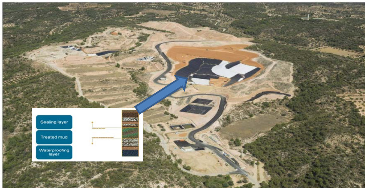
Travaux de conditionnement à la décharge « Racó de la Pubilla »
