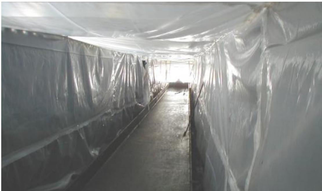
Confinamiento de las celdas (conectadas a la unidad de tratamiento del aire)
