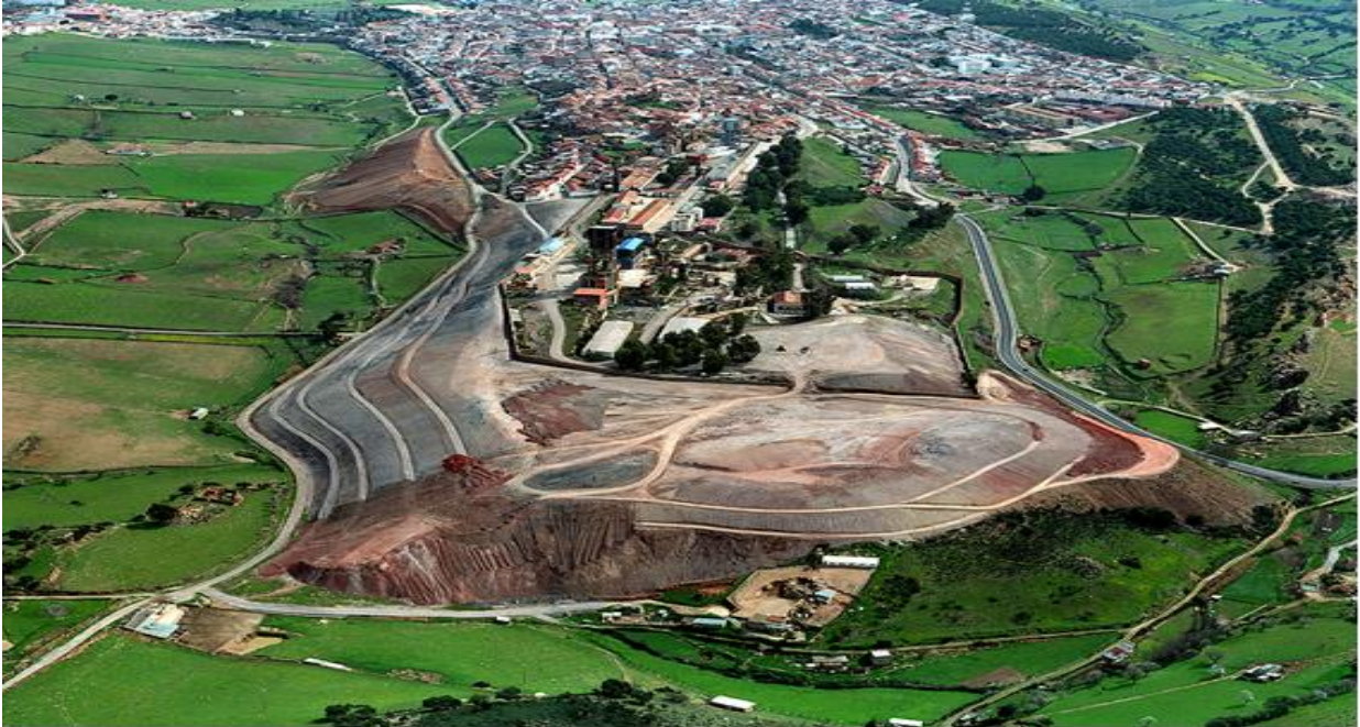
RÉAMÉNAGEMENT DU TERRIL DE "CERCO DE SAN TEODORO" MARS 2006 Photo de Paisajes Españoles
