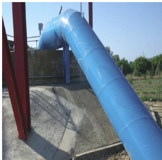
Un des puits construits pour l'approvisionnement en eau potable dans les villes en aval en cas d'urgence
