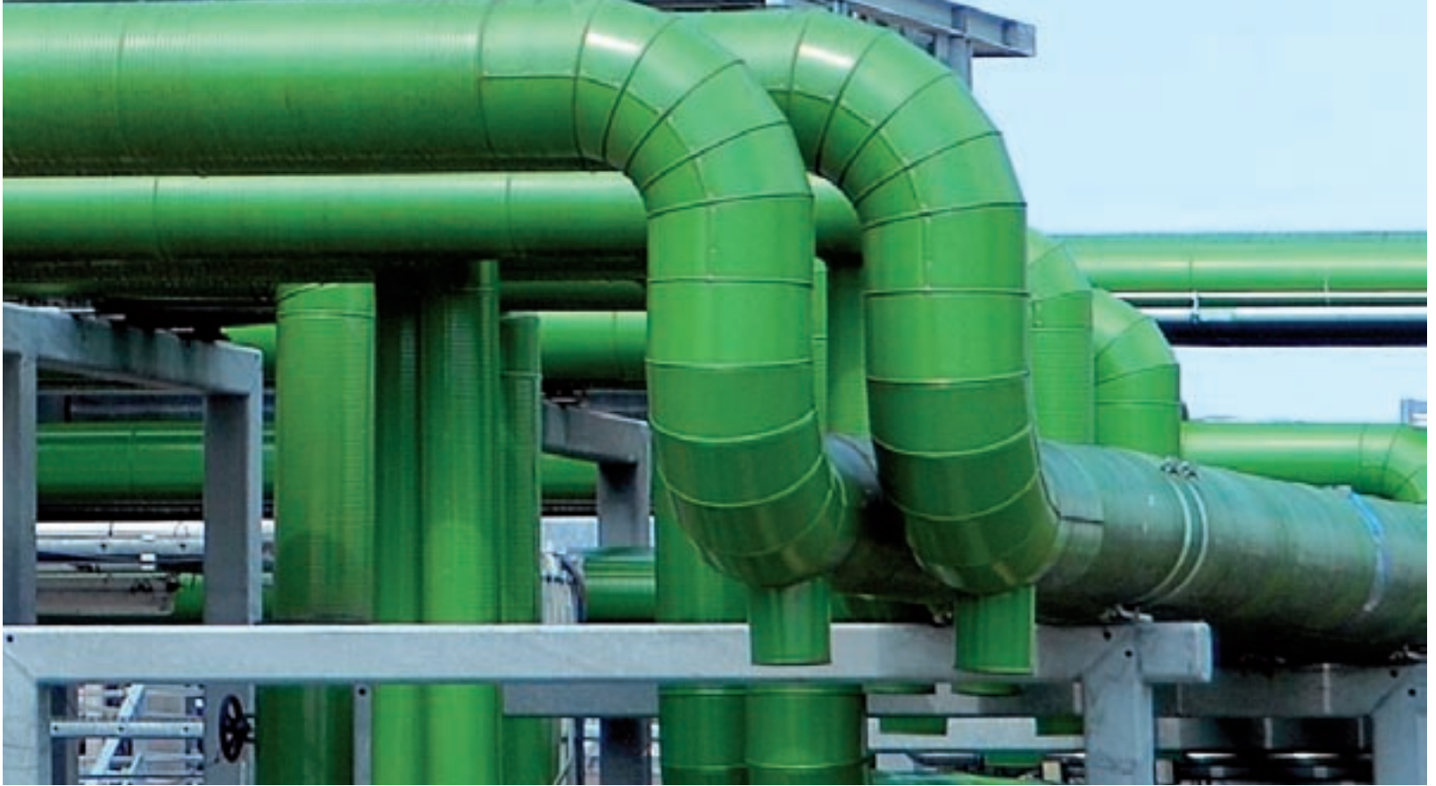
أنايب بخار محطة الطاقة ومنشأة لتحديث الإيثانول تمهيداً لإعادة استخدامه في منطقة التكافل الصناعي كالدنمارك.
