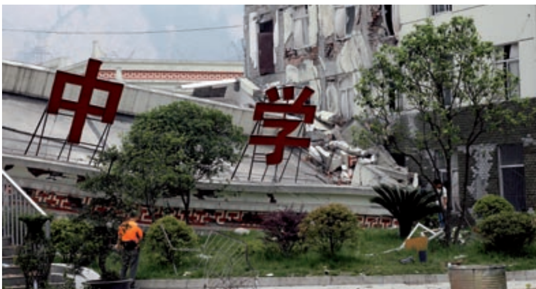
В городе Иньь Зиу (Китай) дети оказались в ловушке после обрушения средней школы после землетрясения в Венчуане 12 мая. Согласно подсчетам, четыре из десяти тысяч жителей города погибли здесь, в эпицентре землетрясения.
