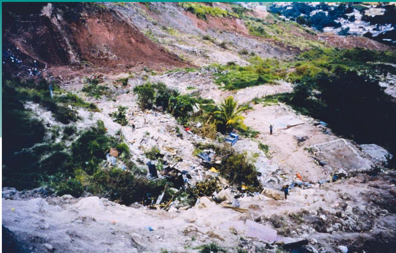
Daños causados por un deslave luego del Huracán Mitch, al que se le atribuyeron cerca de 9,000 muertos y 9,000 desaparecidos, por lo que se lo considera el huracán más mortífero de la historia después del de 1780 en las Antillas Menores. Fotografía: Debbie Larson, NWS Actividades Internacionales, cortesía NOAA.
