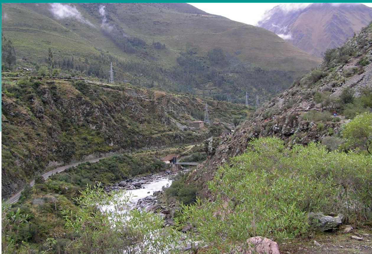
Líneas de electricidad y vías del ferrocarril en el cañón de Urubamba, Perú. Fotografía: Keith M. Davis.
