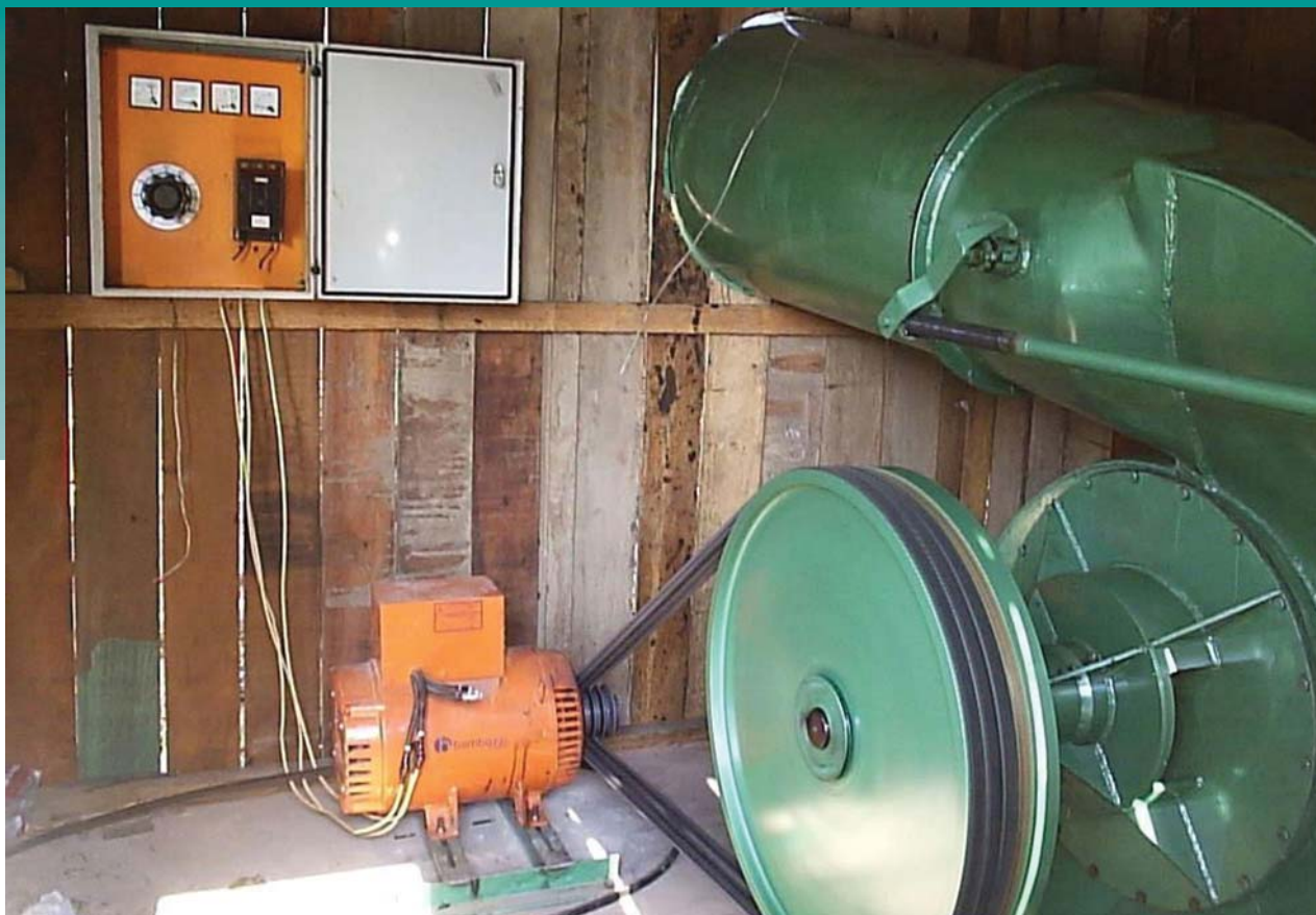
Pequeña turbina y generador de energía hidráulica, que forman parte de un proyecto piloto para instalar una "mini red" de suministro de energía renovable para el lejano pueblo de Cachoeira de Aruã en Brazil, a 145 km de Santerem, sobre un afluente del Amazonas. Fotografía: Indalma Industria/Nazareno Natalino/USAID.
