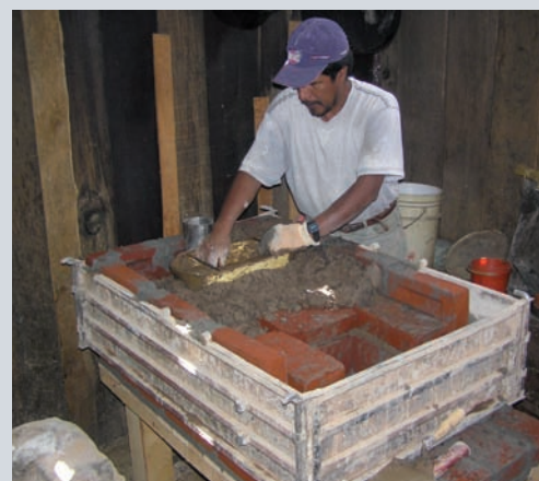
熟练技术人员在 40 分钟内就可以做出一台 Patsari 炉灶。自从使用这些炉灶后，做饭的妇女健康有了明显改善。使用炉灶还能减少空气污染和木材消耗。
