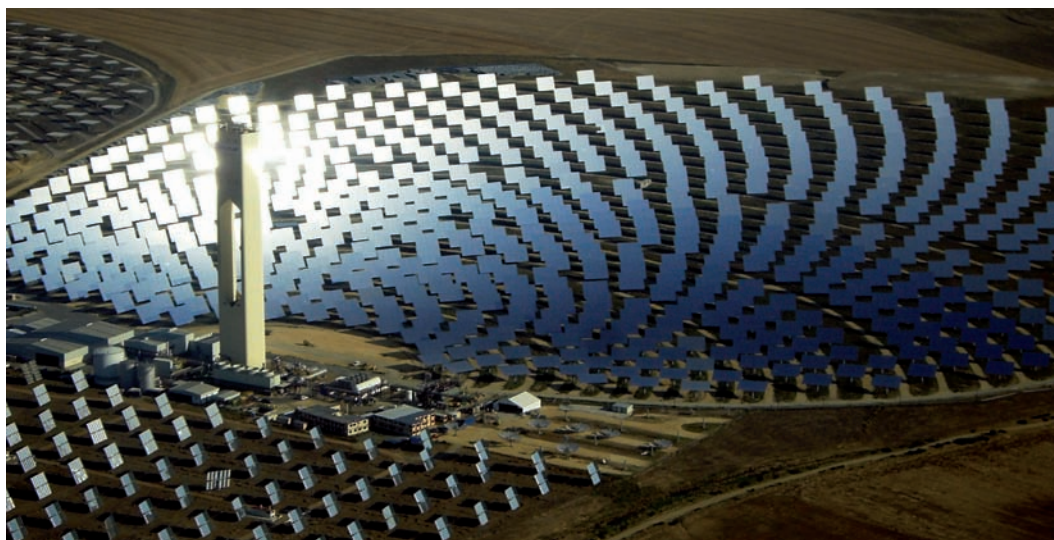
在西班牙，在建的太阳能电池板新工厂PS20毗邻PS10工厂。PS10高115米，由624个装有镜面的日光反射装置提供能源。PS20高165米，由1255个装有镜面的日光反射装置提供能源。PS20的设计产能是其邻厂的2倍，邻厂的产能是1100万千瓦。尽管不是世界上第一个“发电塔”，这两个工厂的规模却是前所未有的。
