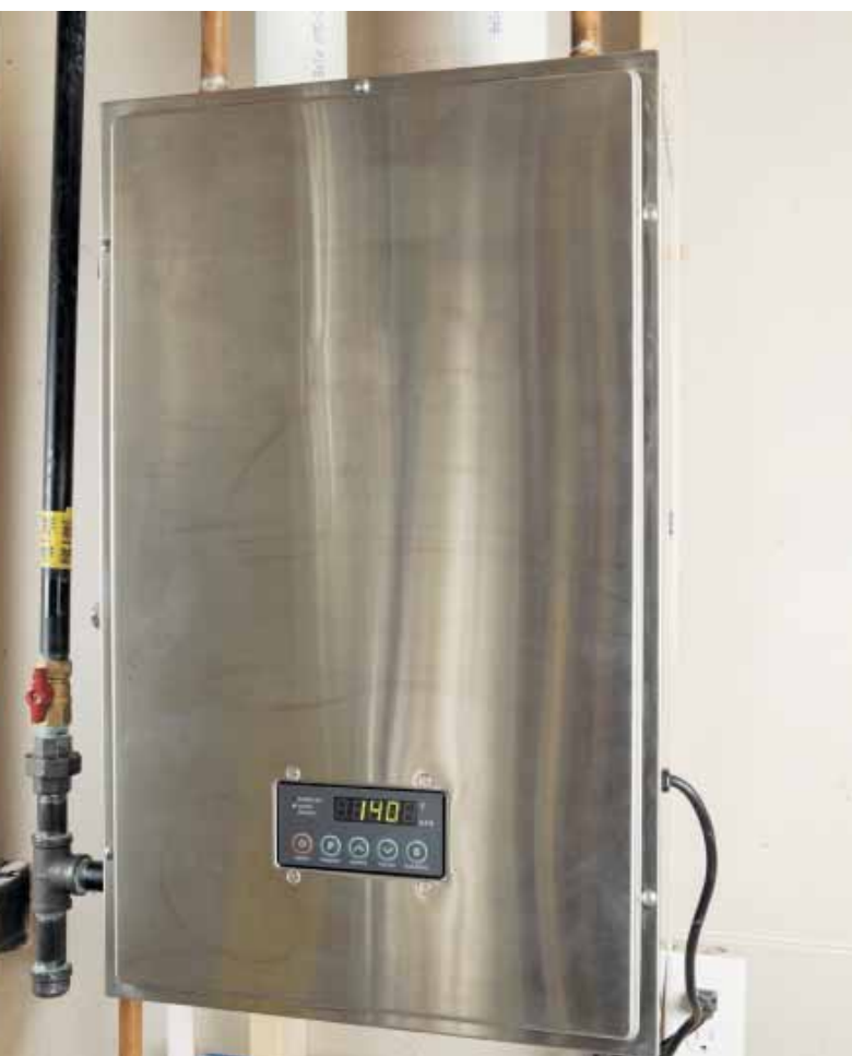
Un calentador de agua residencial a condensación híbrido, sin tanque. Esta tecnología produce agua caliente a demanda y es mucho más eficiente en términos de consumo de energía que un tanque convencional de agua caliente. © BanksPhotos / iStock
