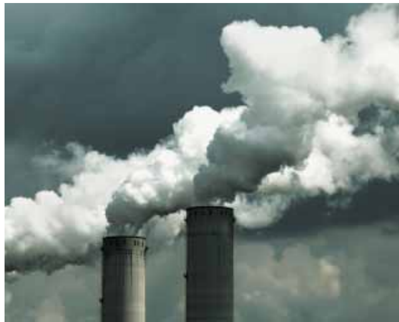
Las emisiones de una termoelectrica que utiliza carbón se elevan a la atmósfera © Sasha Radosavljevic/iStock
