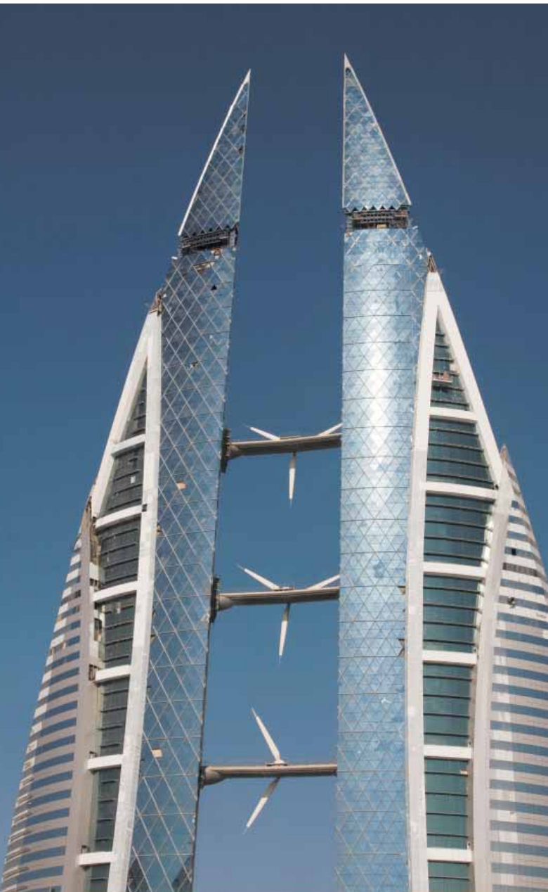
El edificio del Centro Mundial de Comercio de Bahrein, que incluye en su diseño tres turbinas eólicas integradas, hace alarde de poseer el sistema de recuperación de energía de rascacielos más sofisticado del mundo.
