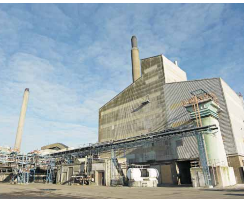
Bajo la regulación REACH de la CE, se requiere que los fabricantes reúnan y registren información acerca de las propiedades de las sustancias químicas que utilizan, en una base de datos centralizada. © Carsten Madsen/iStock
