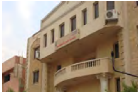
صورة (٢-٤) توضح محطة الرصد الكائنة برئاسة حي المقطم
