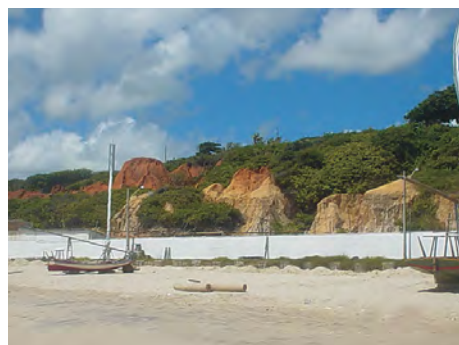
Fotografia 4.5 – Área de construção em frente às falésias – Morro Branco
