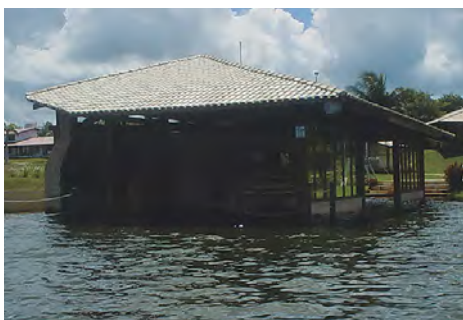
Fotografia 2.7 – Ocupações avançam sobre a margem da lagoa de Uruaú
