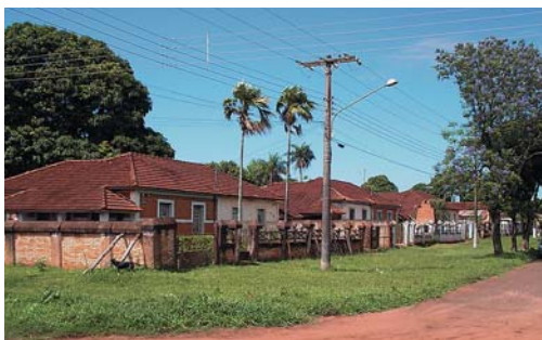
Figura 45 – Vista parcial dos imóveis da Vila Noroeste
