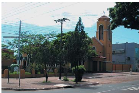
Figura 46 - Foto com vistas parciais do prédio da Paróquia Matriz São José
