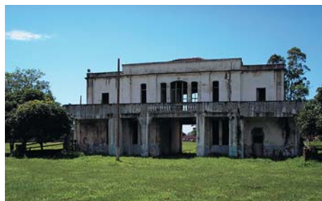
Figura 42 – Vista da fachada de fundos do prédio do Castelinho - 4º Batalhão da Polícia Militar de Ponta Porã
