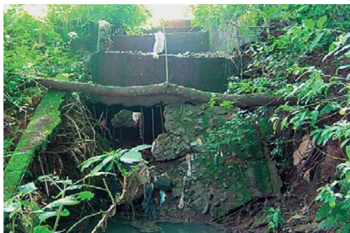
Figura 55 – Vista geral do córrego Ponta Porã
