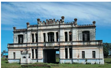
Figura 41 – Vista da fachada de frente do prédio do Castelinho - 4º Batalhão da Polícia Militar de Ponta Porã
