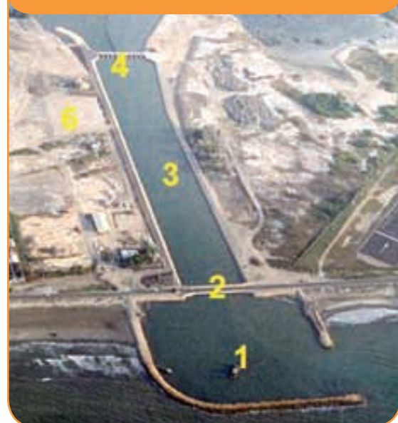
Bocana Estabilizada de Mareas
