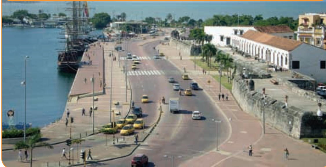
Obras del primer tramo del Sistema de Transporte Masivo - Transcaribe
