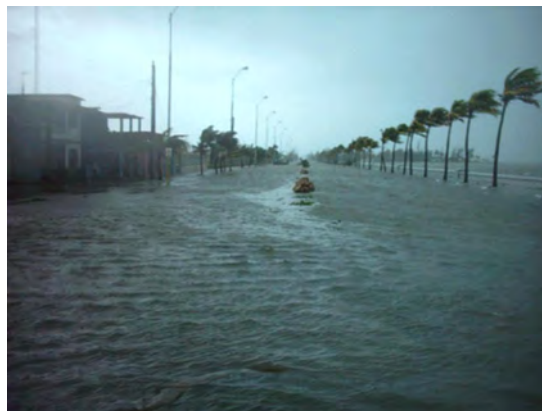
Fuente: Cortesía del Estado Mayor de la Defensa Civil. Fig. 28. Afectaciones del huracán Dennis en el malecón cienfueguero.
