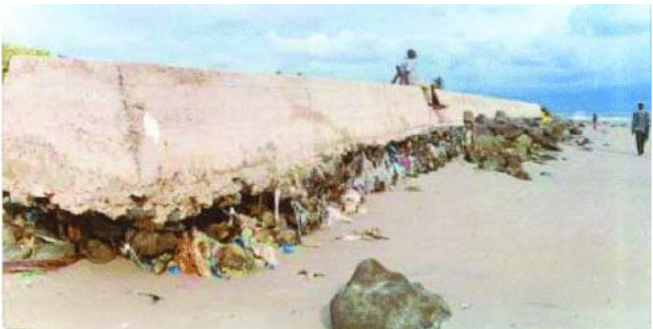
Figure 29 : présentation du mur en béton posé sur des gabions de roches à Diokoul (Niang-Diop)
