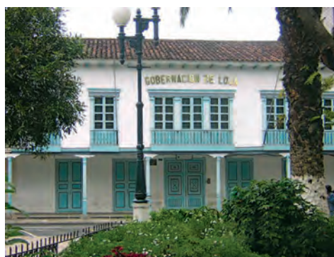
Figura 3.8. Edificio de la Gobernación
