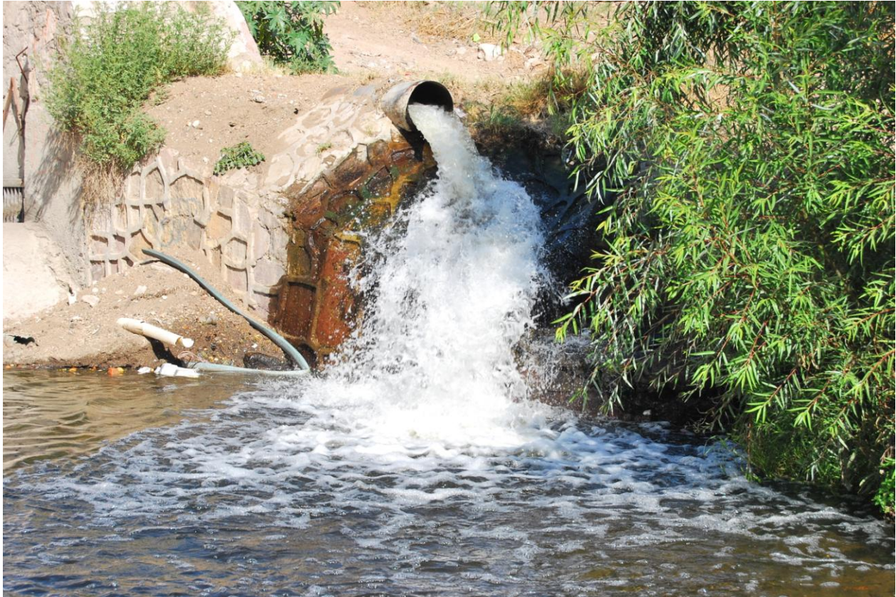
Imagen 6 Descargas Aguas Residuales
