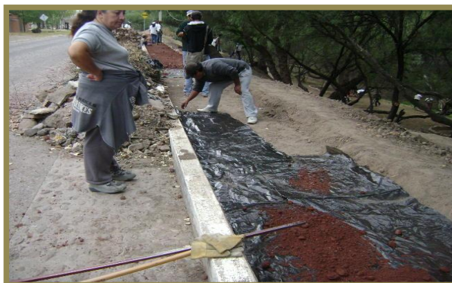
Imagen 38 Restauración de los arroyos “El Molino” y “La Hacienda” Conformación de Sendero
