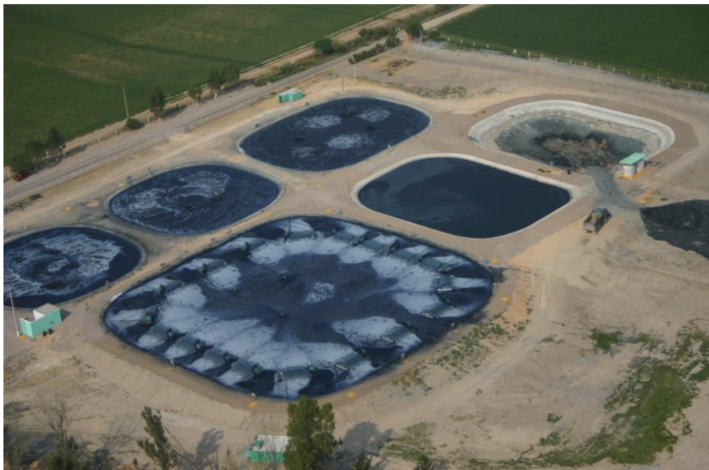
Imagen 6 Planta de Tratamiento Aguascalientes.
