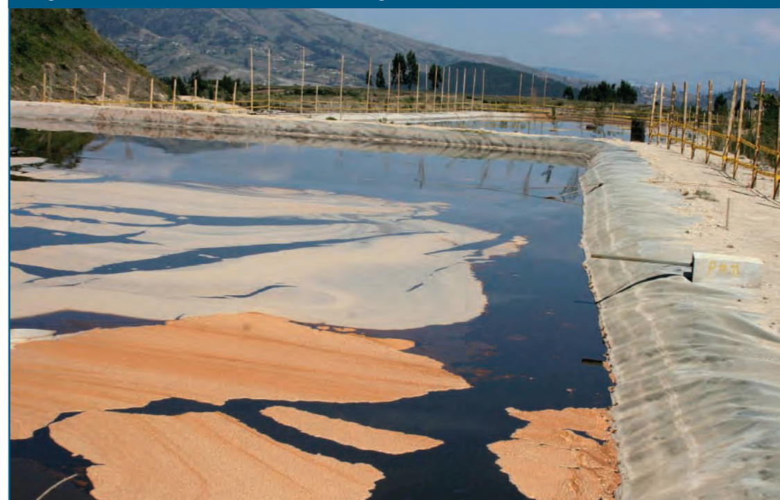
Fotografía N.º 4.3 Piscinas del relleno sanitario El Inga
