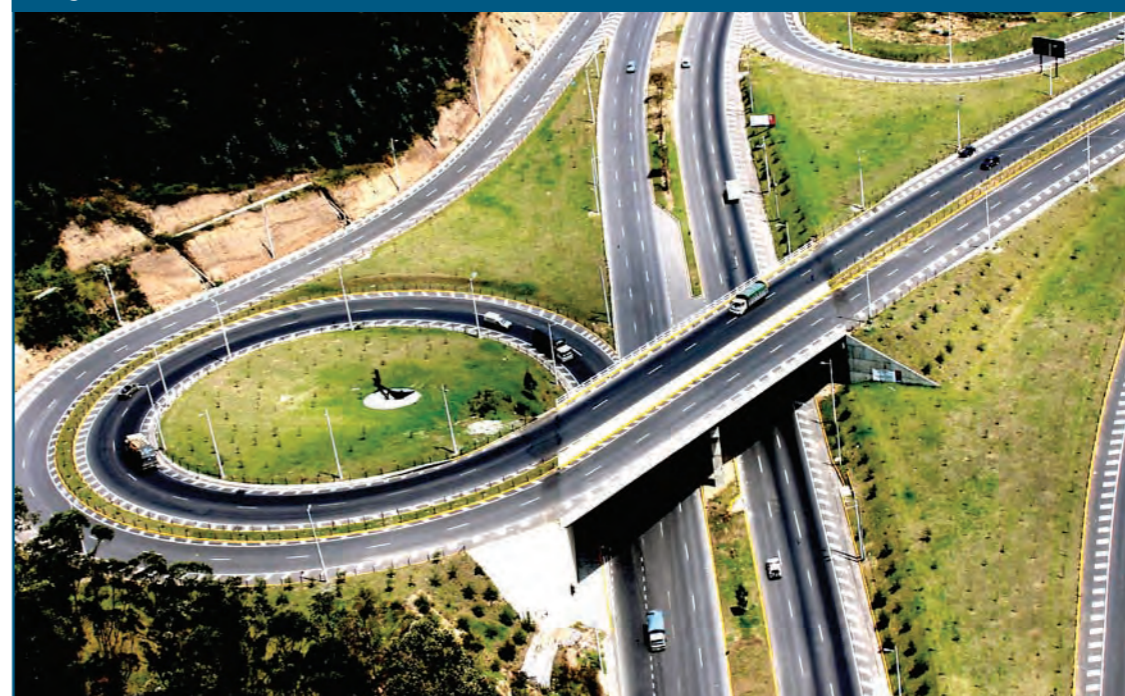
Fotografía N.º 2.14 Intercambiador en la Avenida Simón Bolívar
