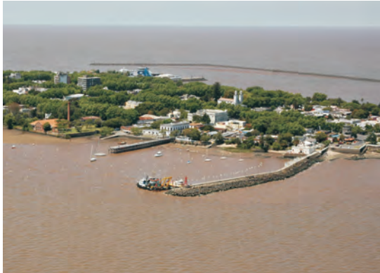
Vista aérea Barrio Sur y puerto deportivo. IMC; 2009
