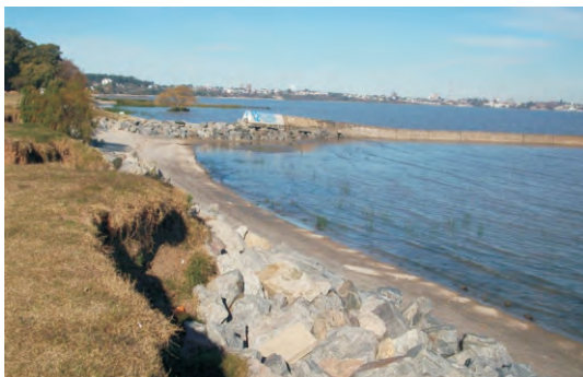
Foto 8. Playa Real de San Carlos, detalle erosión de barrancas. Vega, F; 2009.
